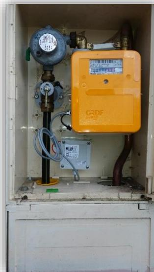
*Capteur LoRa Puls'o raccordé sur la « prise client » d'un compteur GAZPAR*
