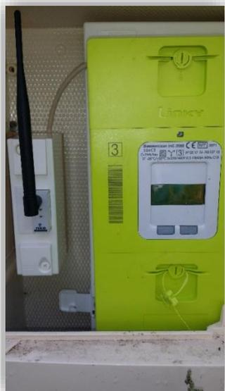
*Capteur LoRa PME/PMI raccordé sur la sortie TIC d'un compteur LINKY*
